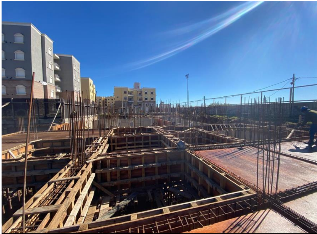
Tabique de hormigón armado y ejecución de vigas y losas en cochera.
