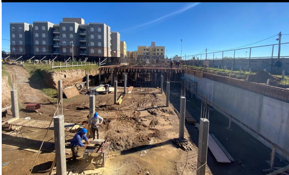
Tabique de hormigón armado y ejecución de vigas y losas en cochera.
